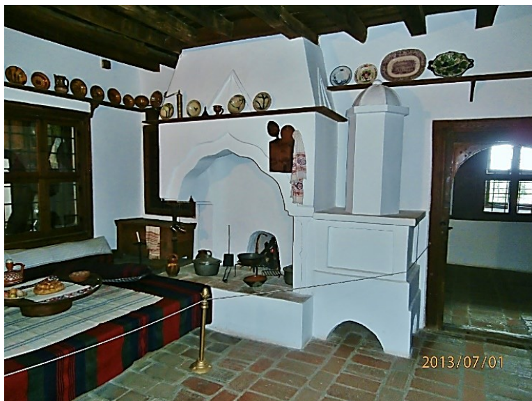
Фигура 325 Комбинация между кухненско огнище и зидана печка в едно пространство. Констанцалиева къща, Арбанаси.
