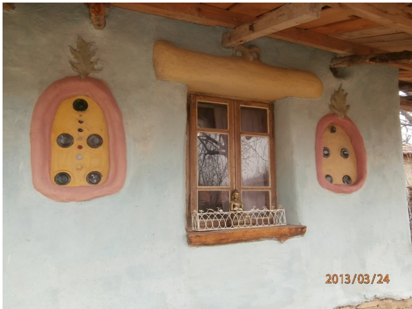
Фигура 286 Глинени мазилки и бои в къща на Сюзън Хаган, с. Хотница. За получаването на някои цветове към глината са добавени и оксидни бои.
