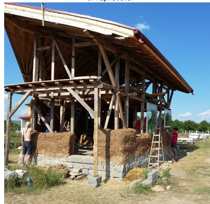
Фигура 136 Изпълнение на пълнеж от коб. Къща в с. Караполци.
