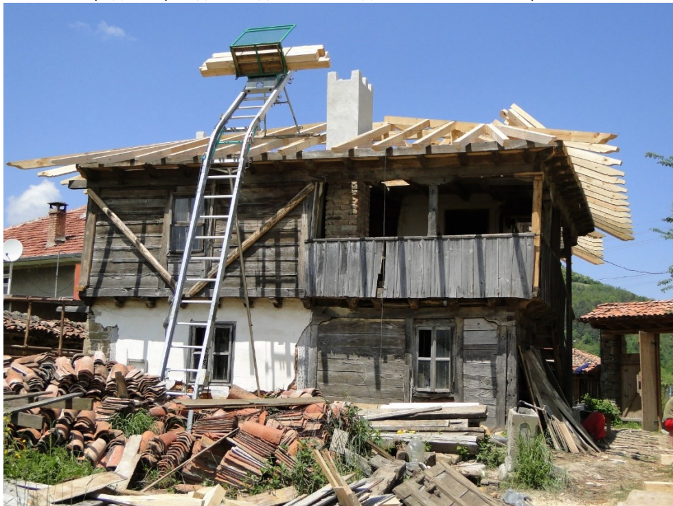
Фигура 308 Цялостен ремонт на покрив. СПОНЕЦ ООД
