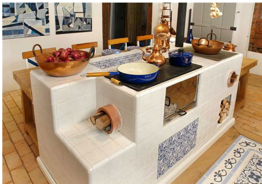
Фигура 337 Кухненска ракетна печка с две горивни камери. permies
