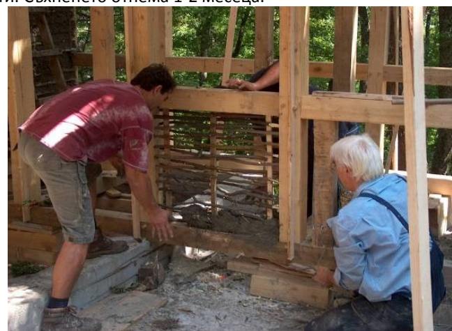
фигура 92 Запъване на плет. Снимка Стефан Шишков.
