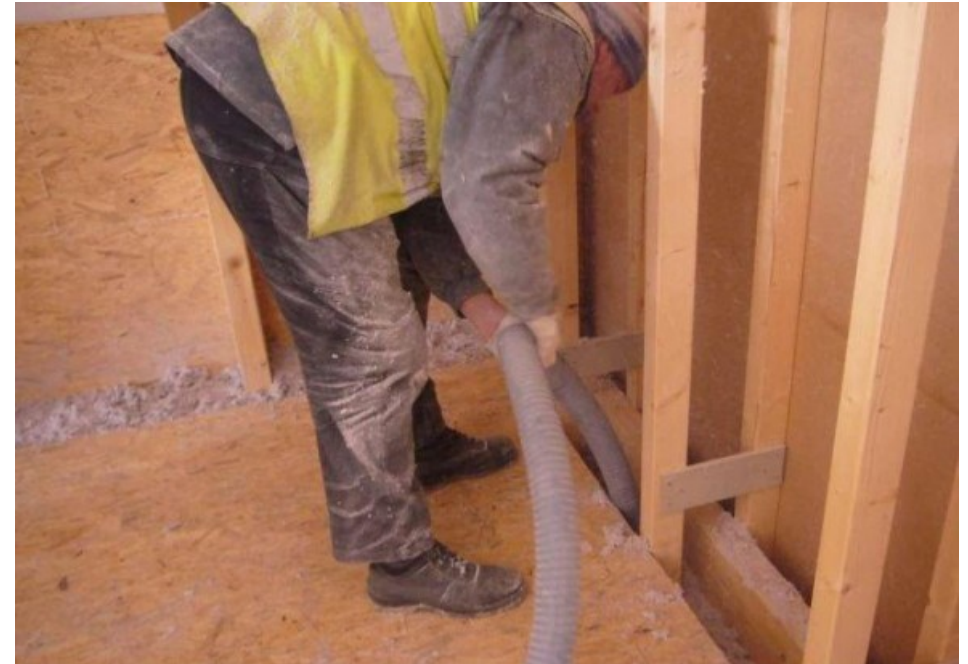
Фигура 176 Машинно полагане на целулозна теплоизолация. homenest
