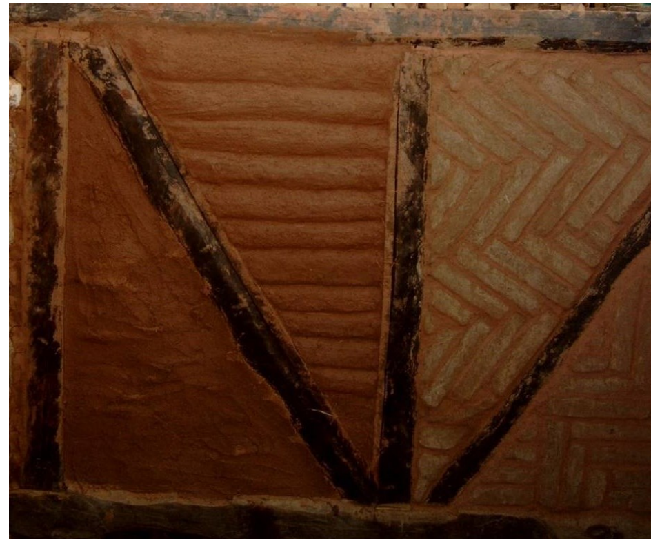
фигура 109 Стена с различни видове пълнеж- плетарка, валци и долма.
