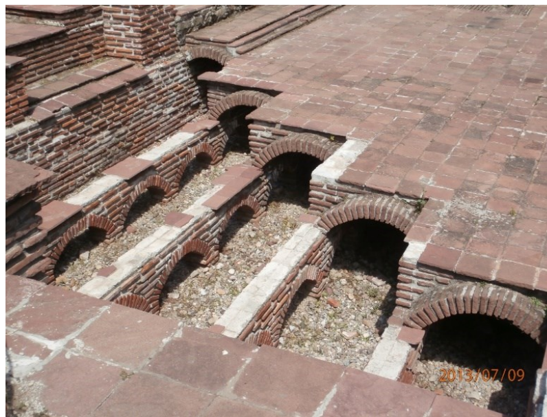
Фигура 320 Хипокауст, оформен с отвори с арки в надлъжните стени и сводове над тях. Кюстендил.
