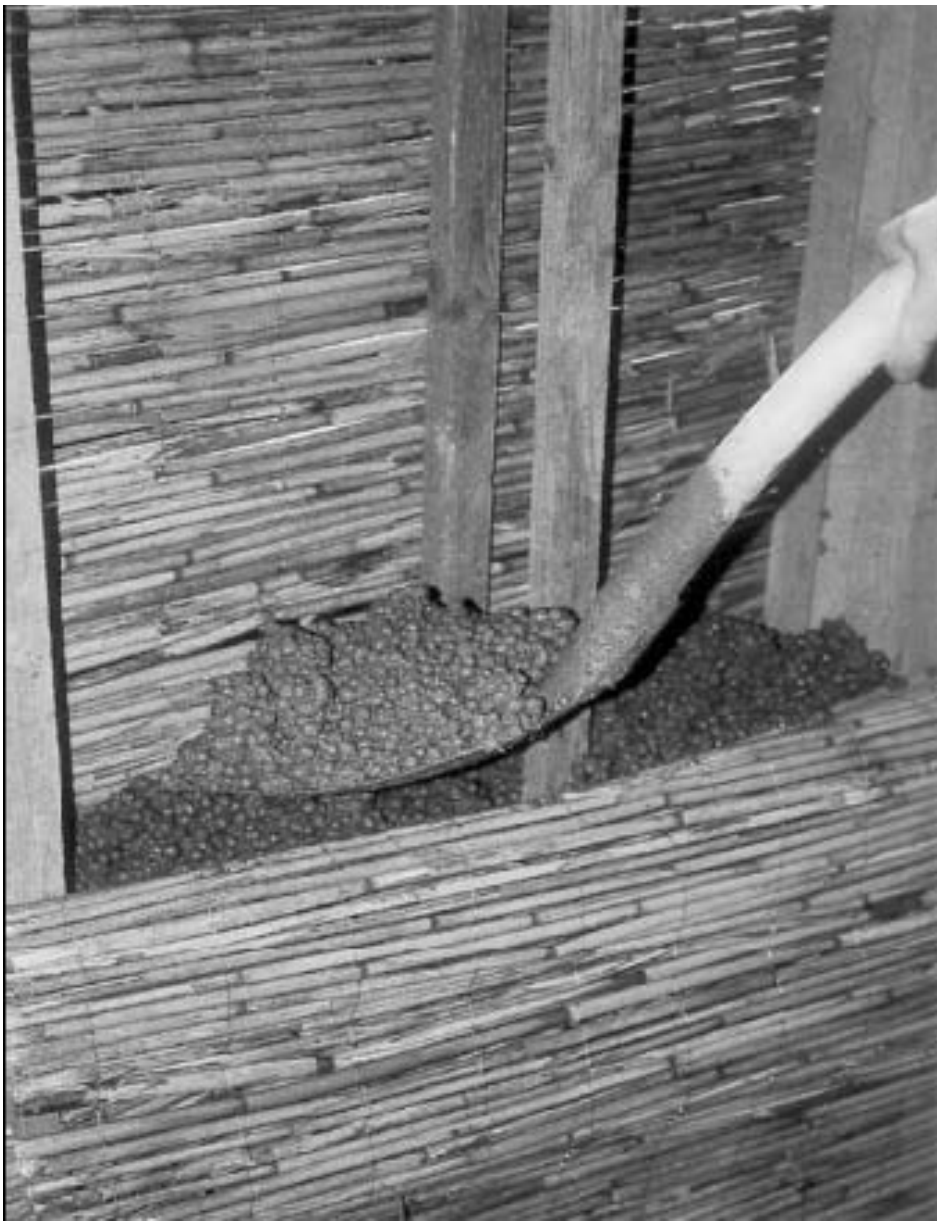
фигура 105 Пълнежна стена с лека глинеста смес с керамзит между тръстикови рогозки. [7]
