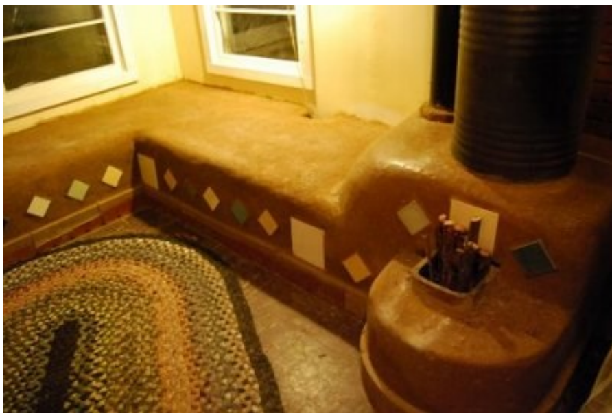
Фигура 336 Ракетна печка с въздуховоди, вградени в акумулираща пейка от глина. richsoil
