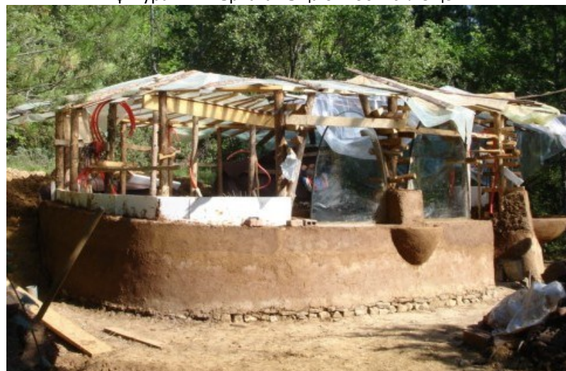
фигура 128 Строителство на къща от коб с вграждане на дървен скелет във вилно селище Омая, Гоцеделчевско. Снимка арх. Б. Буров
