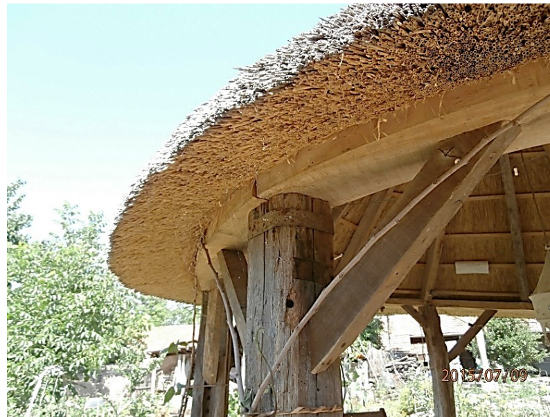
Фигура 210 Детайл на сламен покрив, с. Никюп, В. Търновско.
