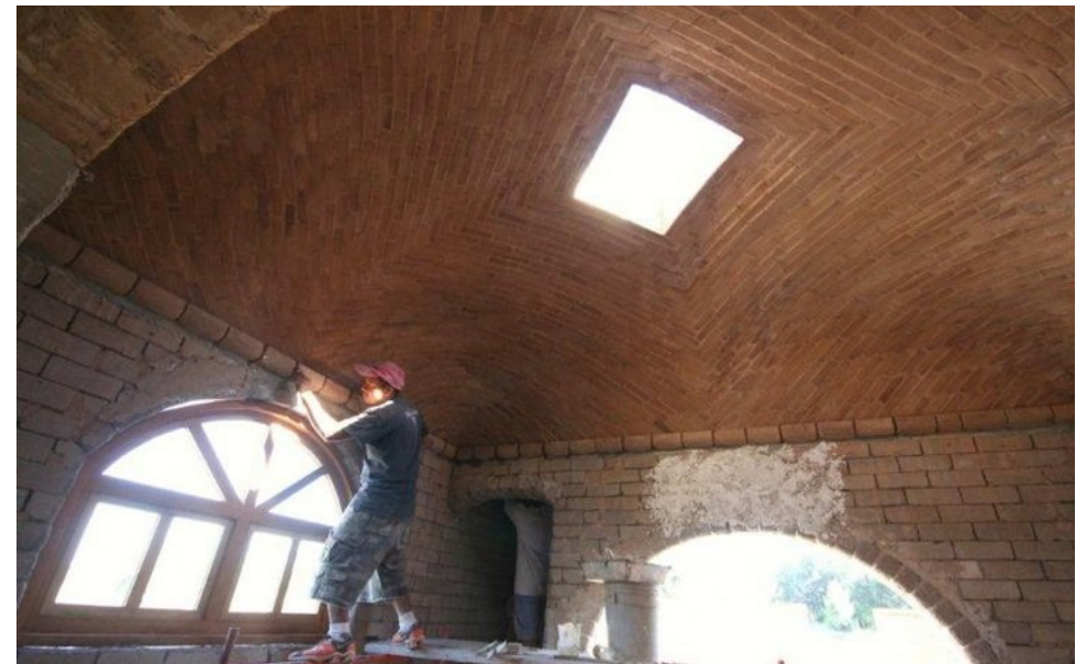
Фигура 244 Купол от пресовани земни блокове, изпълнен без кофраж.
