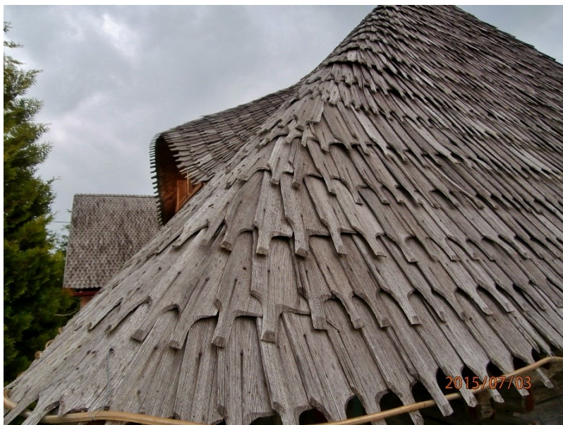
Фигура 191 Гонтова покривка без гльб. Съседните гонти се покриват с половин ширина.
