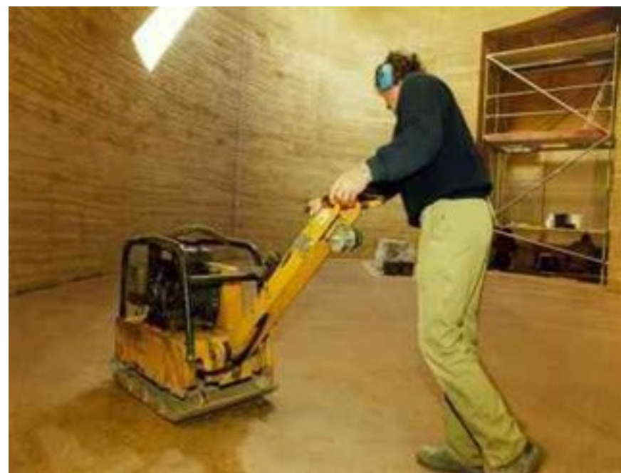
Фигура 161 Направа на глинен под с трамбоване. greenstrides
