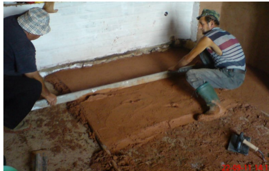
Фигура 160 Направа на подова глинена замазка с мастер и „майки“
