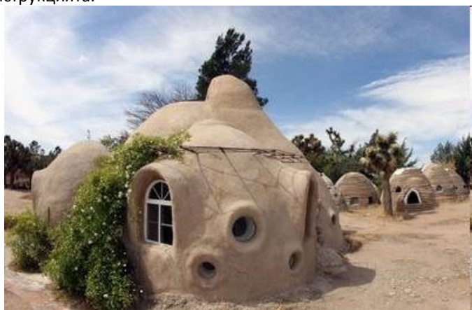
Фигура 256 За предпазване на торбите от слънцето, постоянните структури се измазват.
