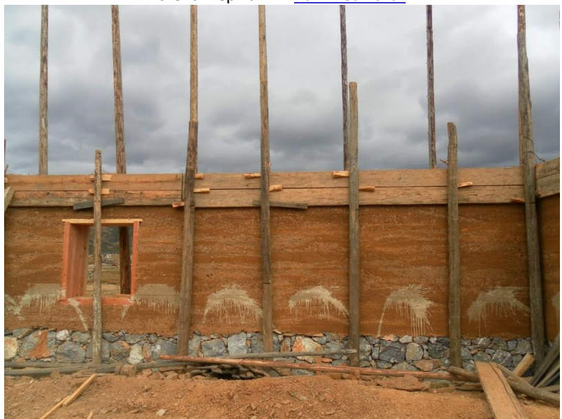
Фигура 144 Хибриден пълзящ кофраж, използван от векове в Китай. Rammed Earth
