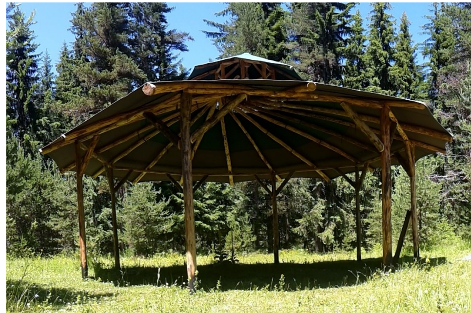
Фигура 262 Реципрочна конструкция в местност Чатъма на язовир Голям Беглик. Арх. Николай Маринов.
