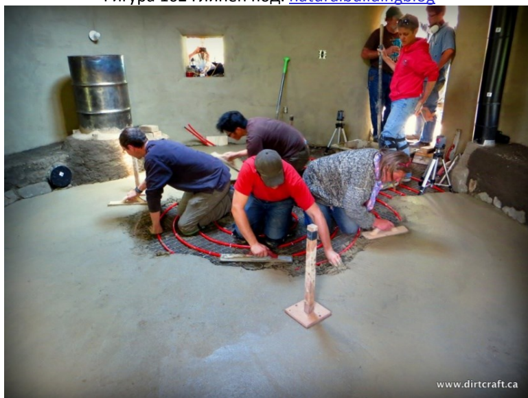
Фигура 163 В глинения под може да се монтира система за подово отопление. vergepermaculture
