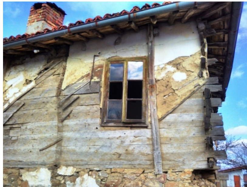
Фигура 63 Талпена къща в Арбанаси. Стените са измазани отвън и отвътре с глинена мазилка, закрепена върху диагонално наковани летви.
