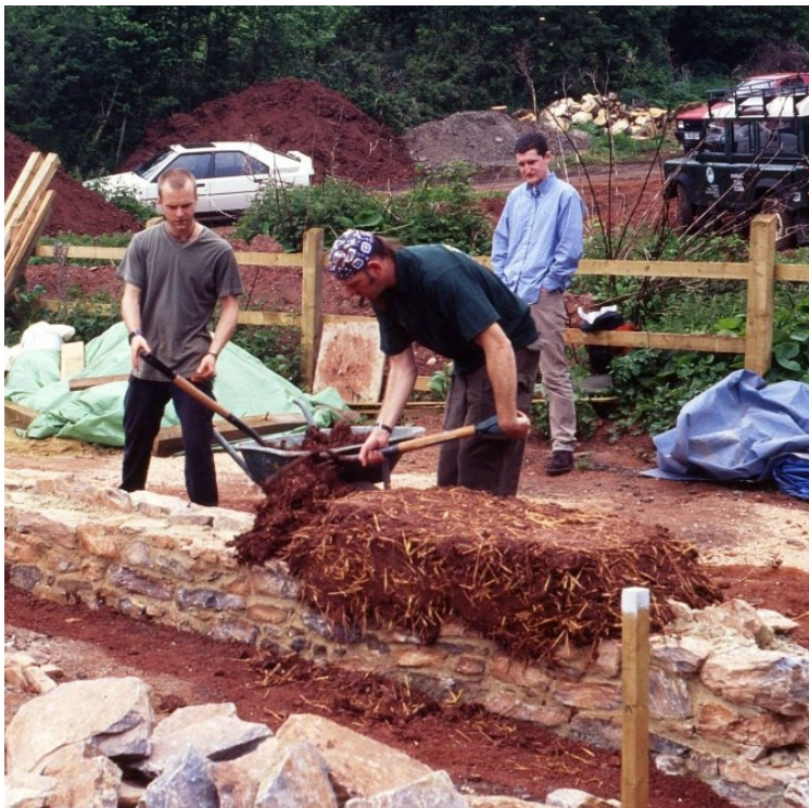
фигура 118 Полагане на сместа върху стената с вила.
