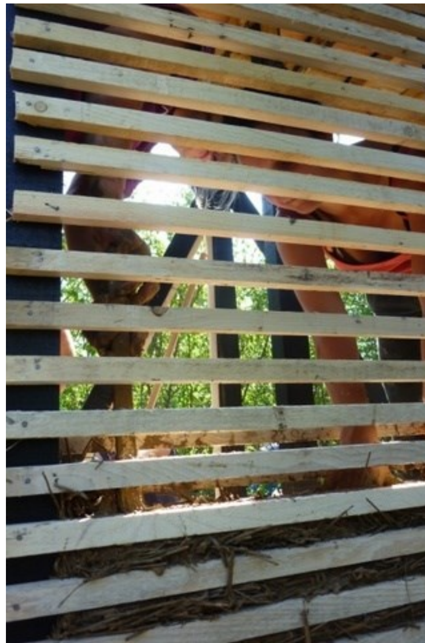
Фигура 104 Направа на стена от олекотена земя с остатъчен кофраж. АСЕМ
