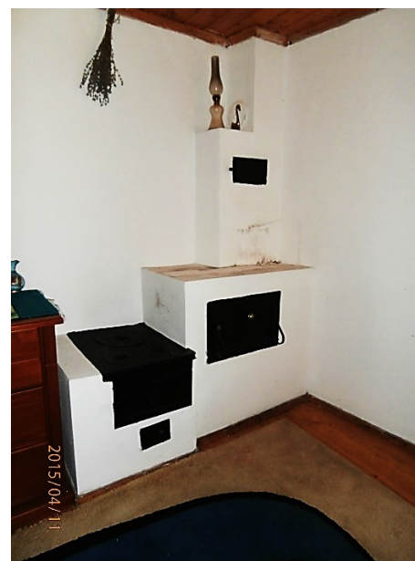
Фигура 328 Традиционна стара зидана печка с плита и фурна за готвене към кухнята и топлообменна част с канали в съседното помещение. С. Миндя, В. Търновско.
