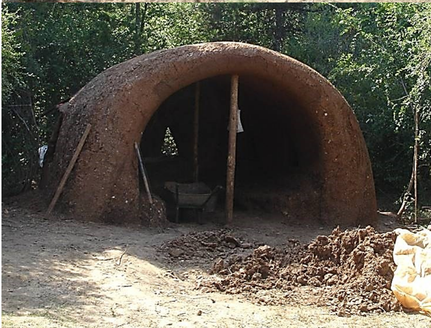
фигура 238 Изпълнение на купол от коб с укрепване от предварително оплетени прътове, вилно селище Омая (сн. Арх. Б. Буров)
