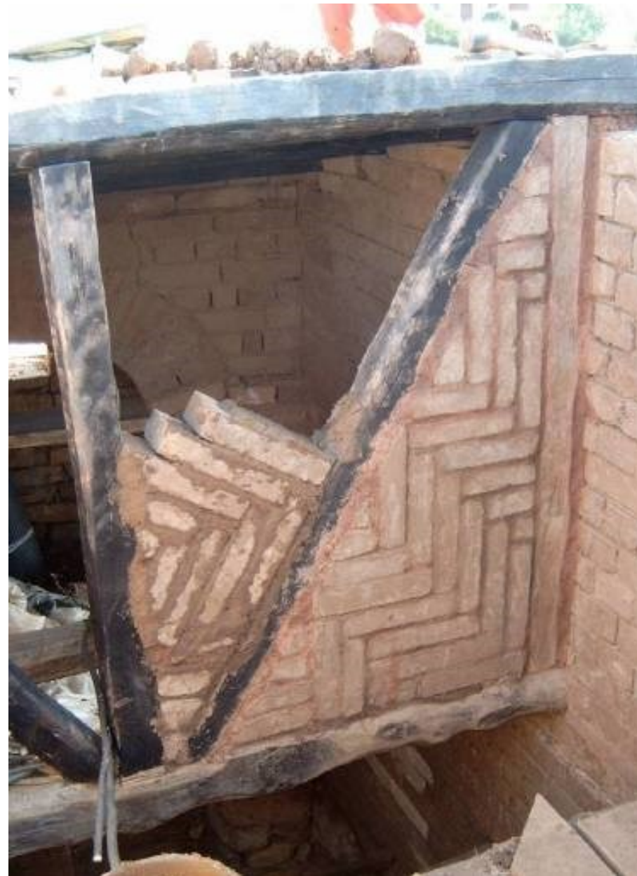
фигура 97 Декоративен пълнеж с пресовани глинени блокове.
