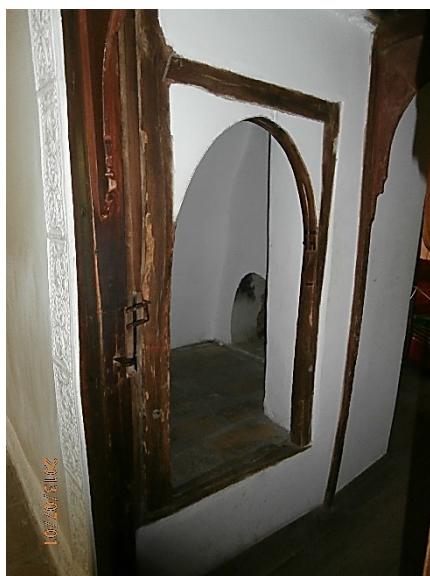
Фигура 326 Зидана печка (ляво), която се пали от обособен килер към коридора (дясно). Констанцалиева къща, Арбанаси.
