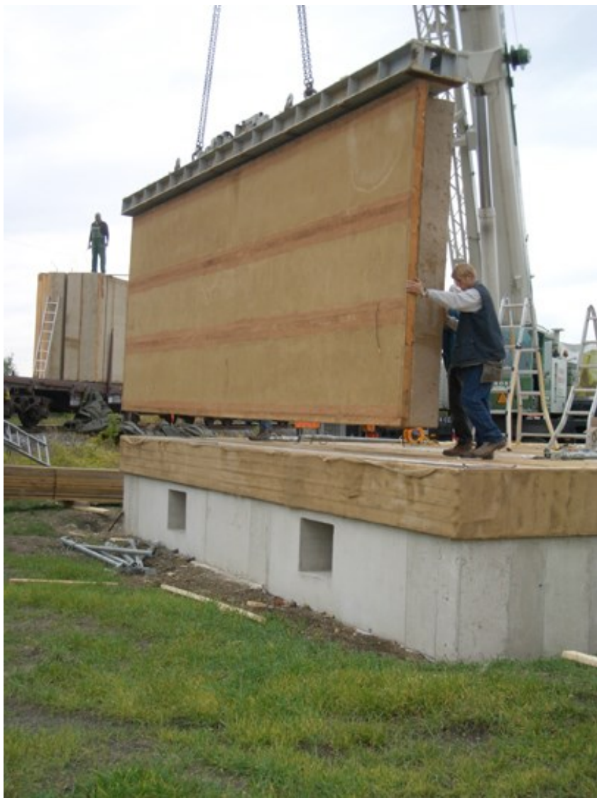
фигура 155 Строителство с панели в Австрия. За строителството на пасивна къща, реализирана близо до Виена, са използвани панели с голям размер. Конструкцията на панелите включва дървена рамка, обкована от двете страни с груби дъски. Пълнежът по средата е от слама. Външната страна на панела представлява 8 см слой от трамбована глина. От вътре са измазани със глина и слама. (арх. Томас Димоф).
