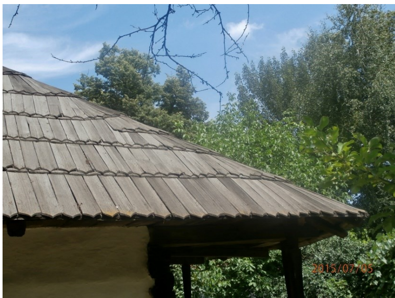
Фигура 199 Оформяне на маия от дървени шиндли чрез подпъхване на допълнителен ред.
