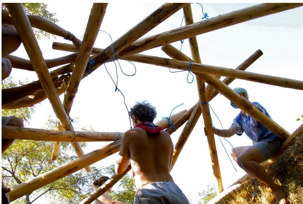
Фигура 261 Направа на реципрочен покрив на експериментална сграда със сламени бали в с. Извор, Родопите. Арх. Николай Маринов.
