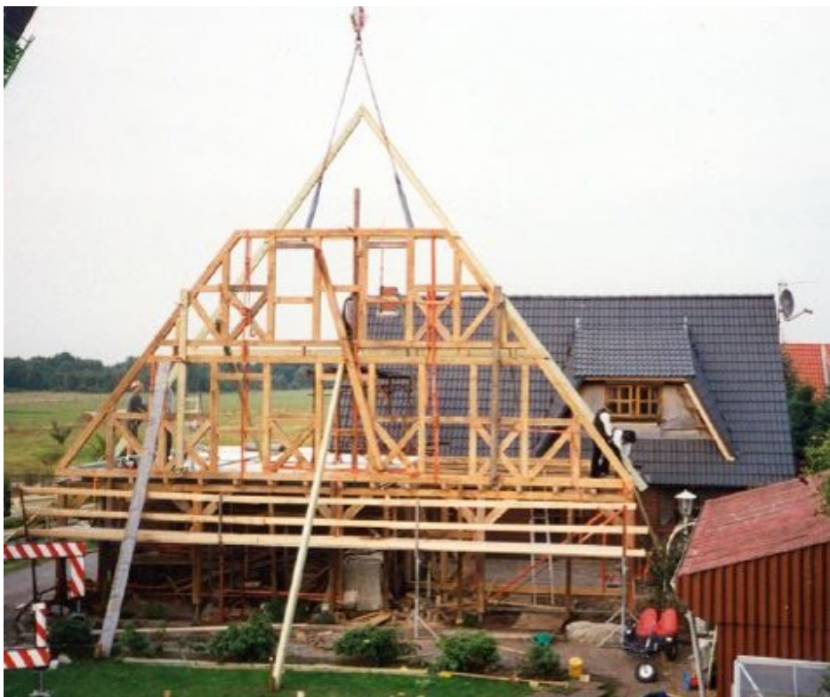
Фигура 88 Монтаж с кран на предварително сглобена паянтова стена.
