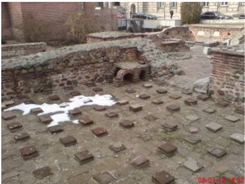
Фигура 319 Останки от хипокауст с арки в двора до ротонда “Св. Георги”, София.
