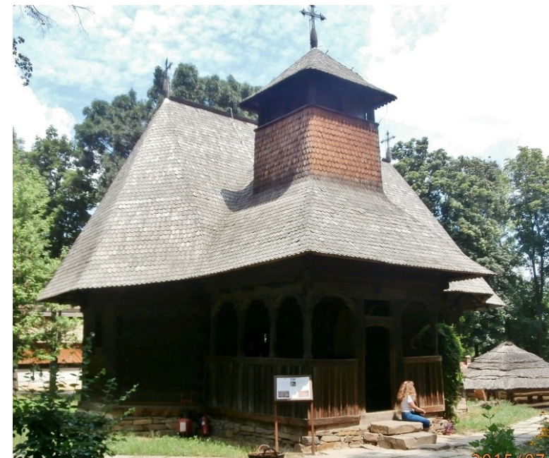
Фигура 197 Дървена църква, покрита с шиндли, от 1773 г. Музей на селото, Букурещ, Румъния.
