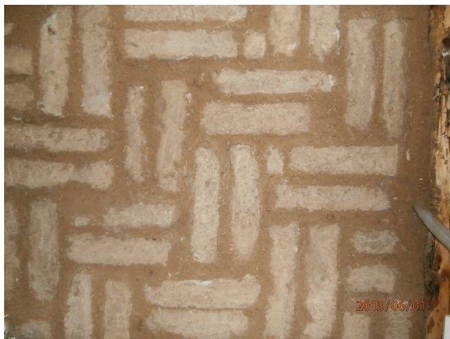
Фигура 274 Пълнеж с кирпич „долма“ на паянтова стена.
