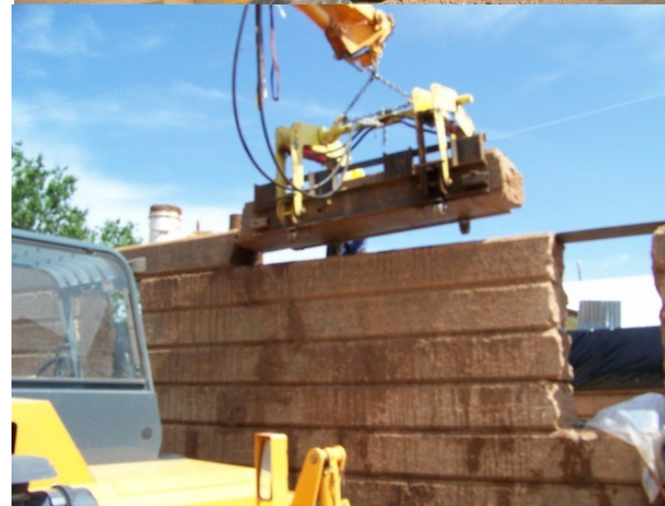
Фигура 156 The EarthCo Megablock е система, разработена в Тексас, САЩ. Използват се екструдирани с високо налягане блокове със сечение 30/46 см и дължина до 3,0 м. (Лари Уилямсън).
