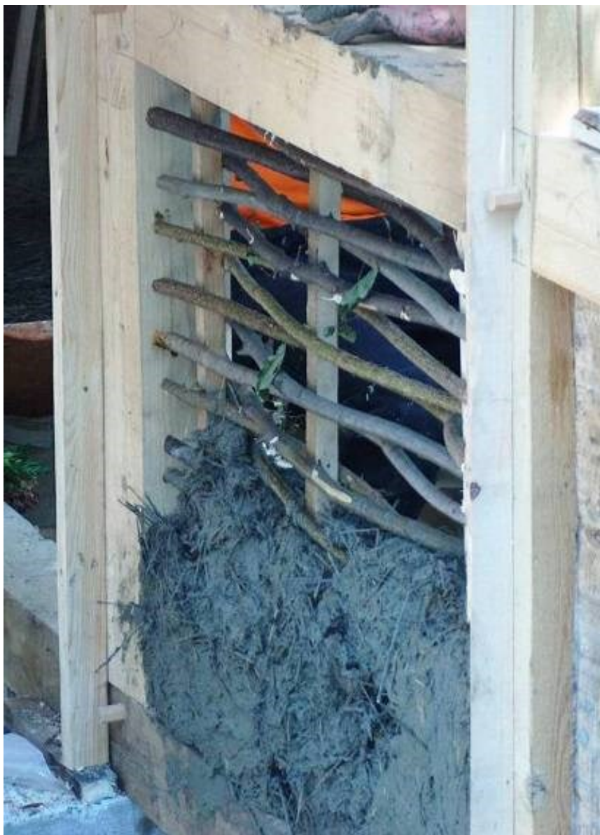
фигура 93 ВАЖНО! При плетенето на хоризонталните пръти е необходимо между тях да се остави разстояние 1-2 см, за да може пълнежът да проникне добре (Снимка Стефан Шишков)
