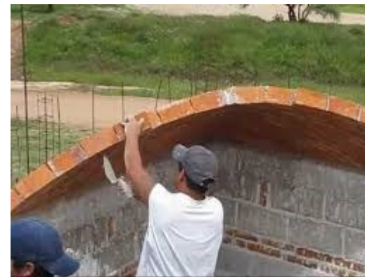
Фигура 244 Купол от пресовани земни блокове, изпълнен без кофраж.
