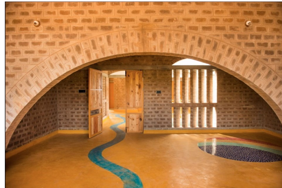
Фигура 224 Арка от пресовани земни блокове. Индия. Biome Environmental Solutions
