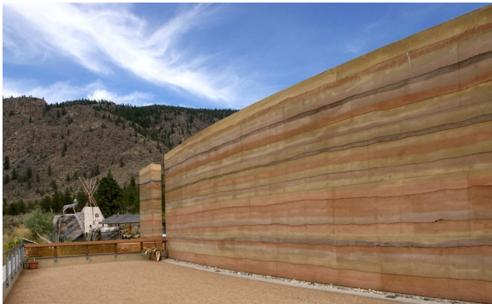
Фигура 280 Индиански културен център в Канада Nk'Mip Desert Cultural Centre . За построяването на стената от стабилизирана с цимент трамбована земя са използвани 16 вида земя с различни цветове. Материалът е доставен от райони, обитавани от 16 индиански племена.
