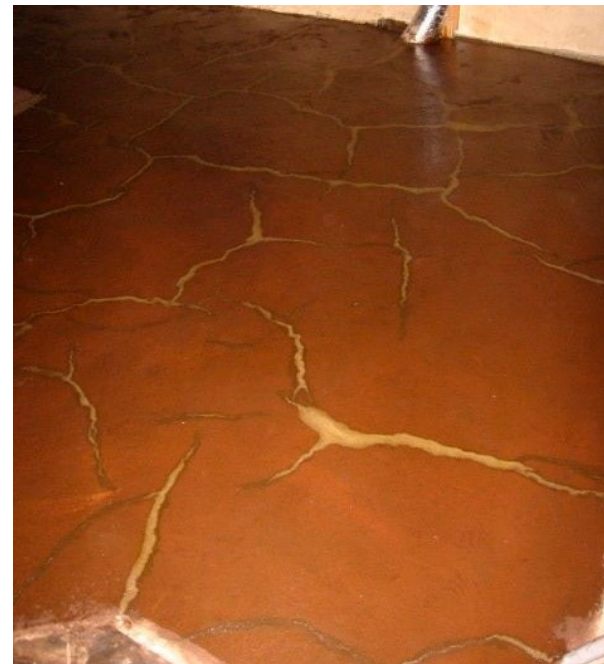
Фигура 164 Декоративен ефект при запълване на пукнатините с различен цвят. endeavourcentre.org
