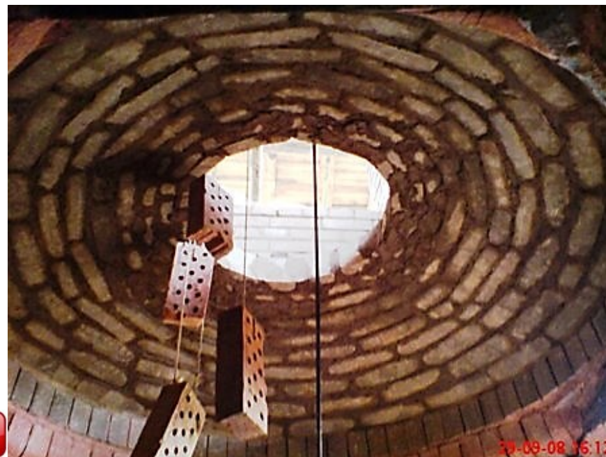
Фигура 241 Купол от пресовани земни блокове. Временното закрепване на тухлените редове става с висящи тежести.
