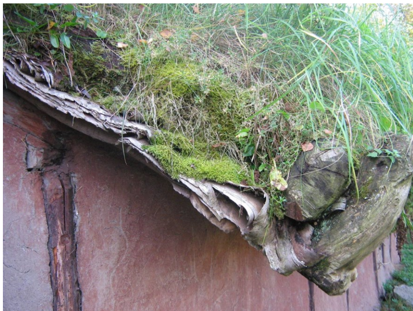
фигура 201 Детайл от торфен покрив , Норвегия.
