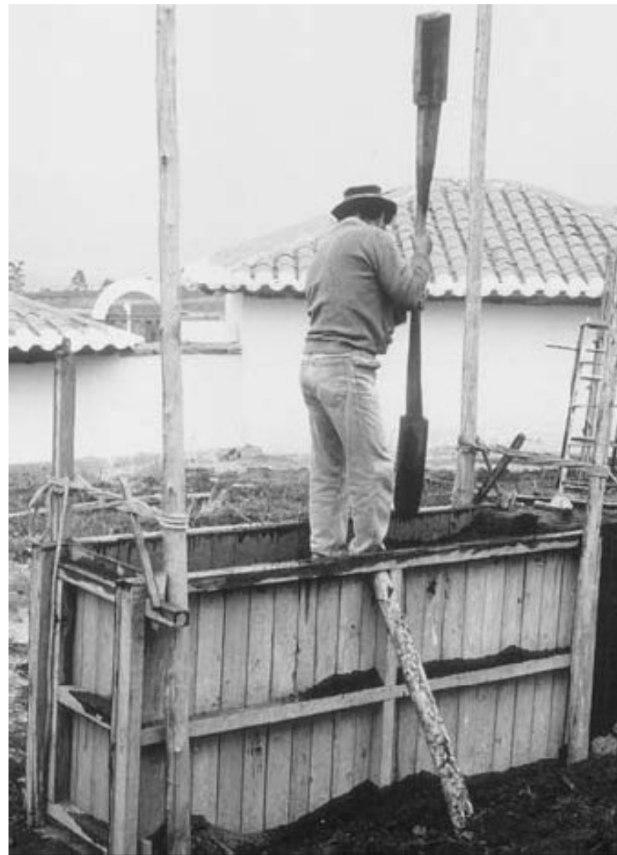
фигура 148 Дървена трамбовка с различни краища- правоъгълен и объл коничен. [7]
