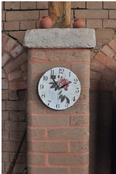
Фигура 273 Носеща стена с декоративна фигурана зидария от пресовани земни блокове.
