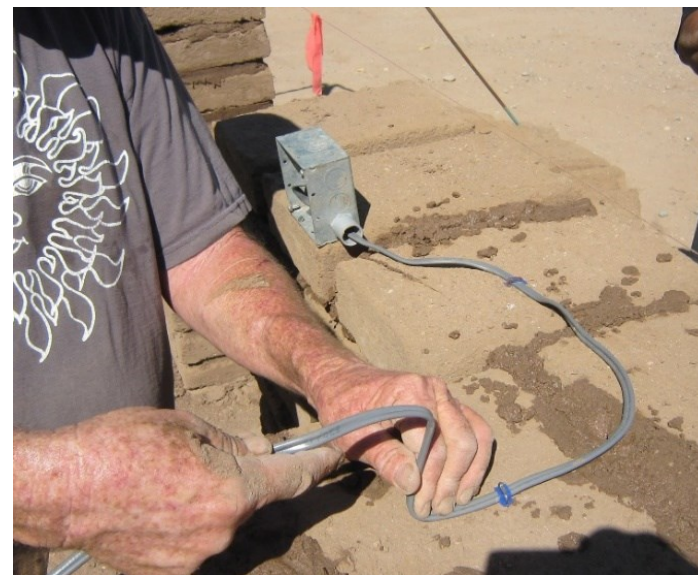
фигура 80 Полагане на електрическа инсталация по време на зидане.
