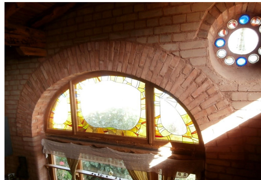
Фигура 225 Елипсовидна арка (с два радиуса) на отвор 3,0 м.
