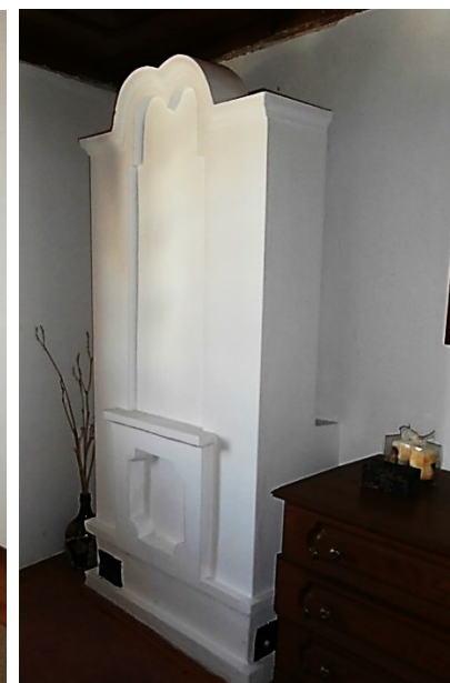
Фигура 328 Традиционна стара зидана печка с плита и фурна за готвене към кухнята и топлообменна част с канали в съседното помещение. С. Миндя, В. Търновско.
