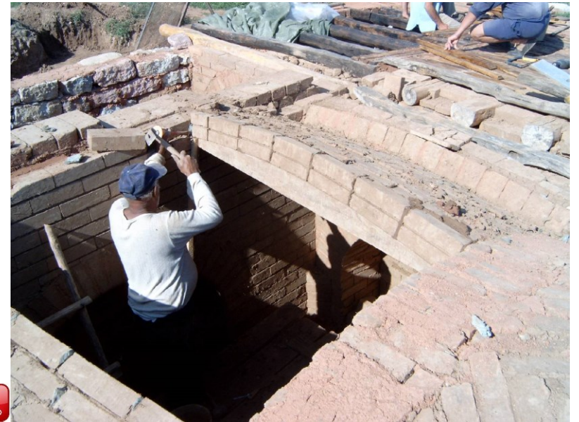
Фигура 237 Направа на свод без кофраж чрез зидане на редове-арки, успоредни на основата (базата).
