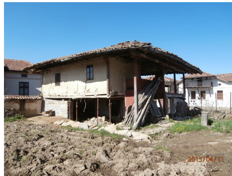
Фигура 307 За подмяна на каменния зид етажът е подпрян на телескопични метални кофражни подпори. Къща в с. Миндя, В. Търновско.
