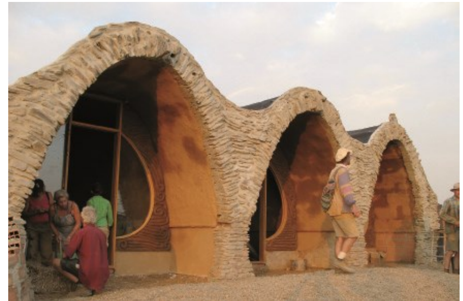
Фигура 26 Сводова конструкция от бали слама за селската комуна Tamera в Алентехо / Португалия, проектирана от Гернот Минке. lernpunkt.lehm
