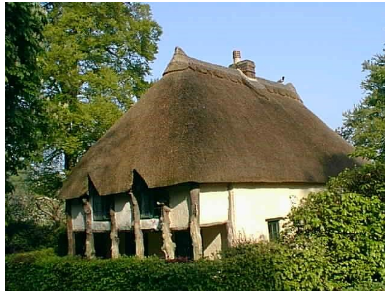
фигура 217 В Англия и Западна Европа за билото се използва дебел слой от слама, привързана с лико, защото тръстиката е твърда и не позволява огъване. Къща в Кокингтън парк, гр. Торки, Югозападна Англия.
