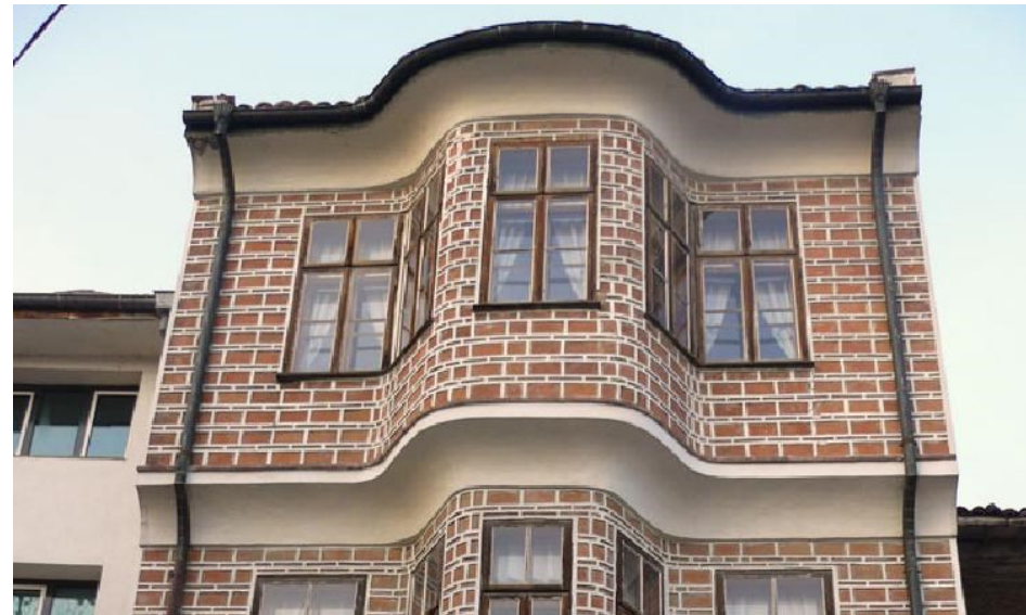
Фигура 102 Тухлена облицовка на паянтова стена, Къщата с маймунката, В. Търново, Майстор Колю Фичето.
