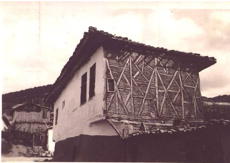
фигура 95 Пълнеж „долма“ с тънки кирпичи. Къща в Шумен.
