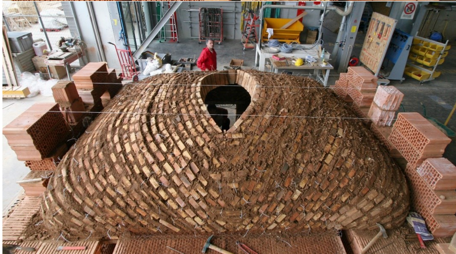
Фигура 243 АВГАНСКИ КУПОЛ . Използва се за покриване на помещения с правоъгълна форма. Състои се от арки, наклонени под 30 градуса. Зидането започва едновременно от всички ъгли докато арките се заключат в центъра на купола. Стая с размери 4/4 м се покрива за половин ден от пет човека. По време на зидането в широката част на фугите се поставят камъчета, които заклинват реда. Това позволява на работниците да се движат от външната страна на купола преди втвърдяване на свързващия разтвор. Така се избягва направа на работно скеле от вътрешната страна. Снимка CRATERRE
