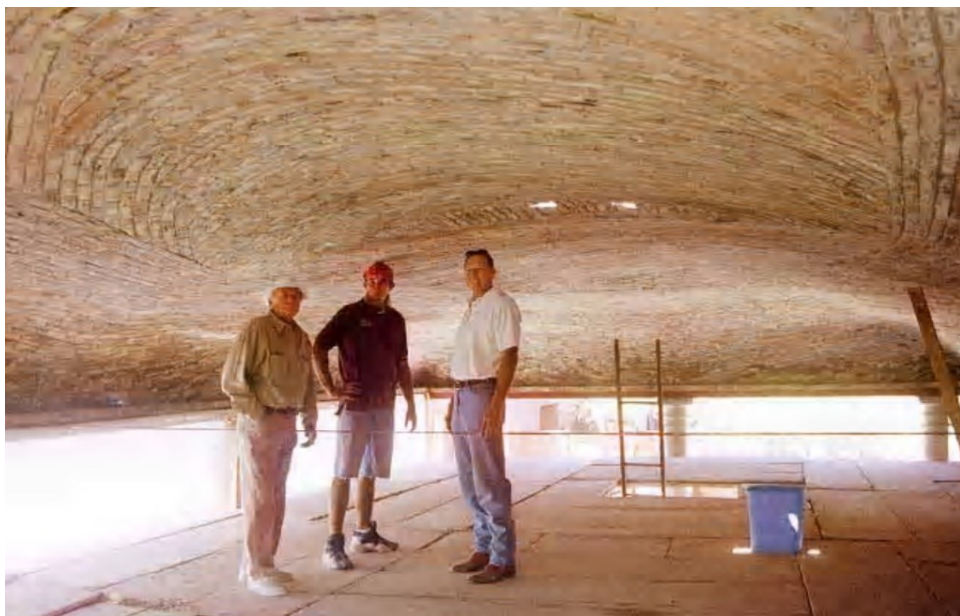
Фигура 245 Купол с размери 7,32/13,42 м, построен от Джо Файт в къща близо до Феникс, Аризона.
