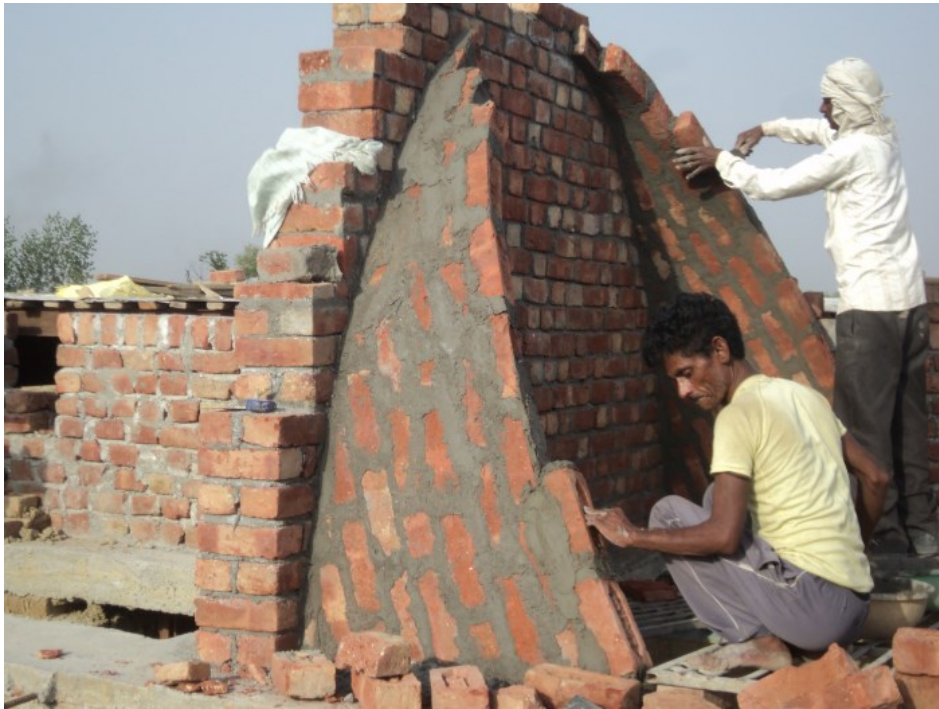
Фигура 235 Строителство на нубийски свод. Siddharth Menon Architect
