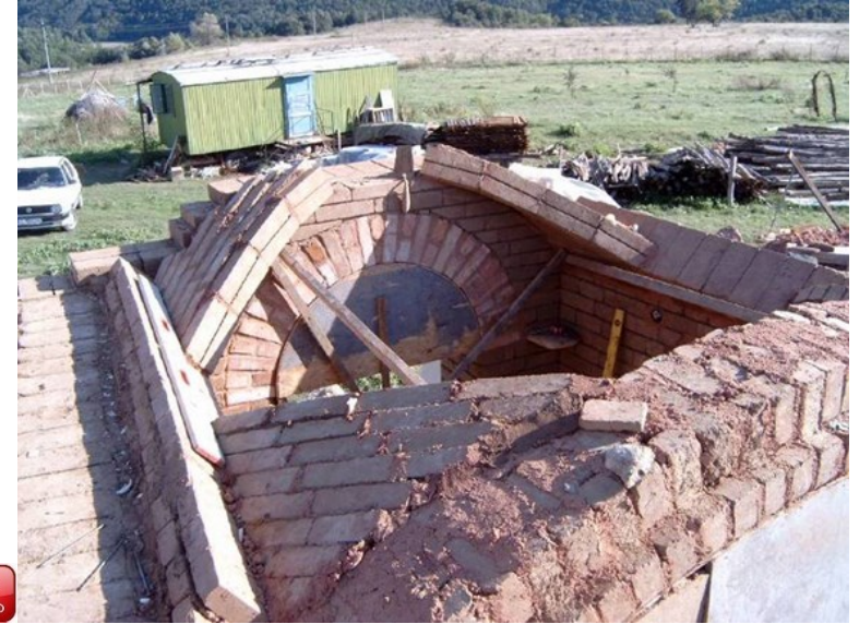
Фигура 236 Направа на свод без кофраж чрез зидане на редове-арки от ъглите към центъра.
