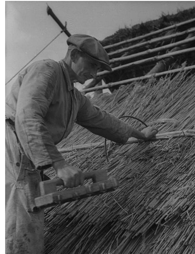
фигура 214 Закрепване на тръстиката чрез пришиване. [22]
