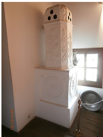
Фигура 326 Зидана печка (ляво), която се пали от обособен килер към коридора (дясно). Констанцалиева къща, Арбанаси.
