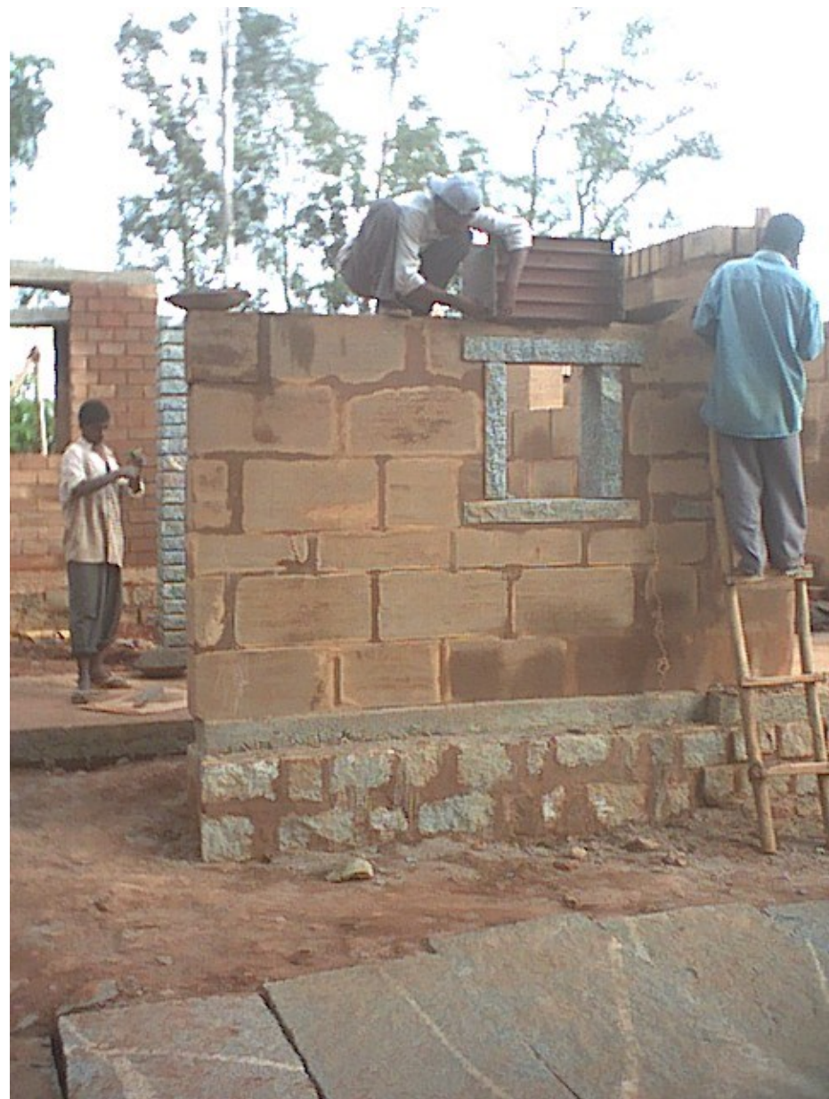
фигура 145 Метален маломерен подвижен кофраж, Индия. Дневната производителност на двама работника е 14 блокчета.
