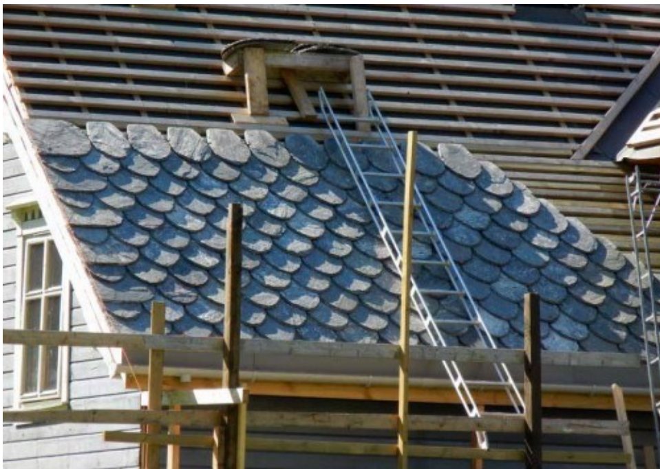
Фигура 186 Покриване със шистови плочи. mkmgrup.eu
