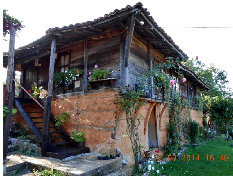
Фигура 66 Къща с талпено-стълбова система в с. Бръшлян, Странджа.
