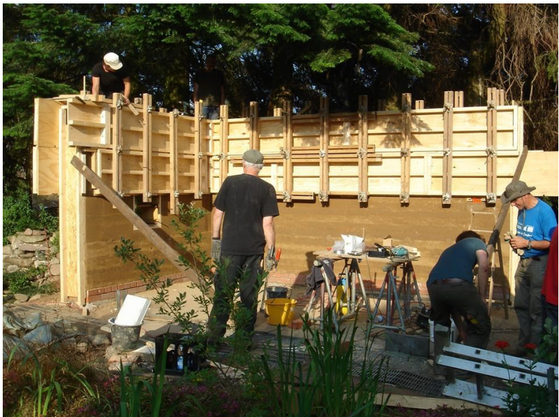
Фигура 143 Пълзящ нагоре подвижен дървен кофраж по продължение на цялата стена. Германия. Rammed Earth
