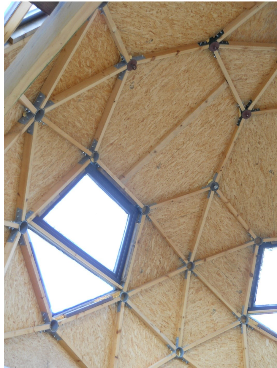
Фигура 270 Жилищна сграда в гр. Павел Баня . Конструкцията на покрива е геодезически купол от II-ри клас с диаметър 7м и покрива 35м 2 . арх. Георги Рафаилов
