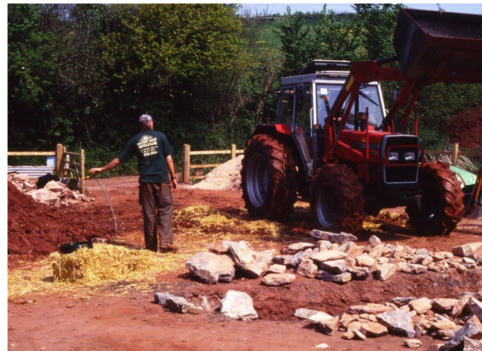
фигура 116 Смесване на глинеста почва и слама с трактор, Англия.
