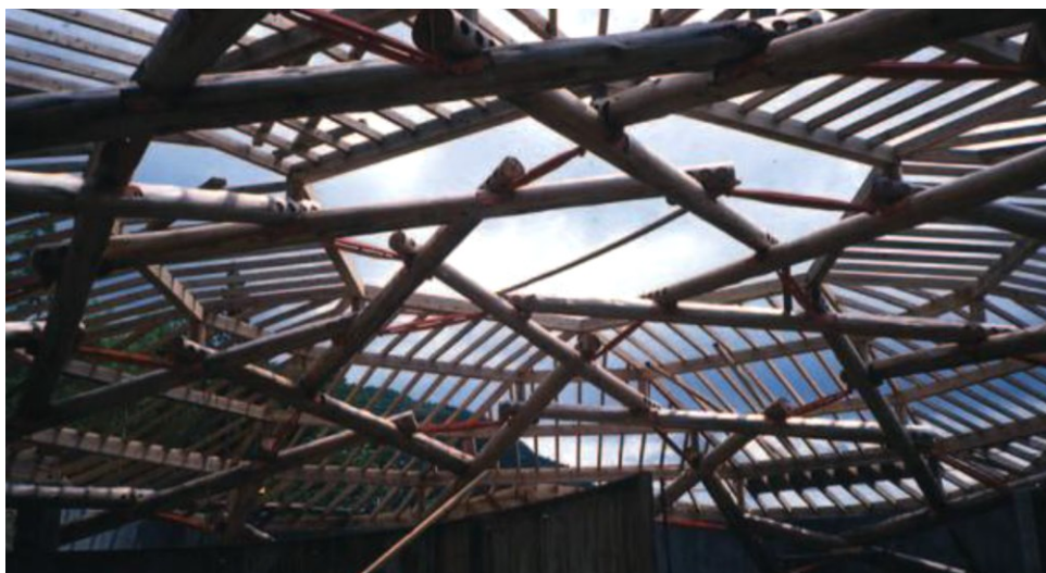
Фигура 267 Покривна конструкция от реципрочен купол с метални обтегачи. Музей на каменната зидария в Япония. [24]
