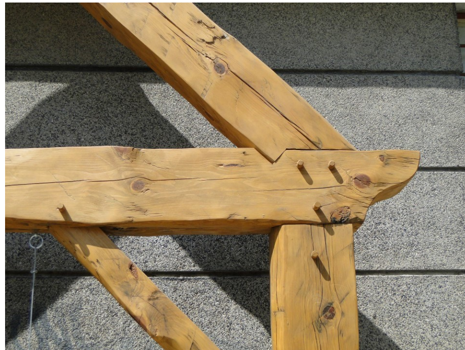
Фигура 309 Детайл на конструкция от ръчно дялани греди със сглобки. СПОНЕЦ ООД
