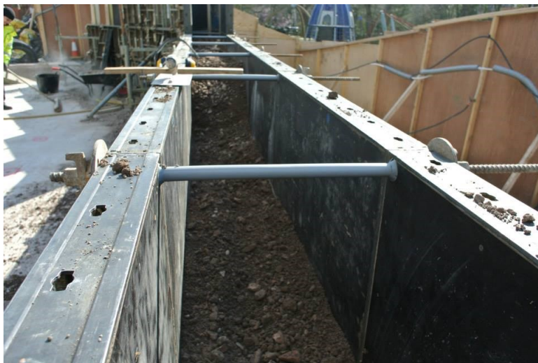
фигура 142 Статичен метален кофраж. Rammed Earth
