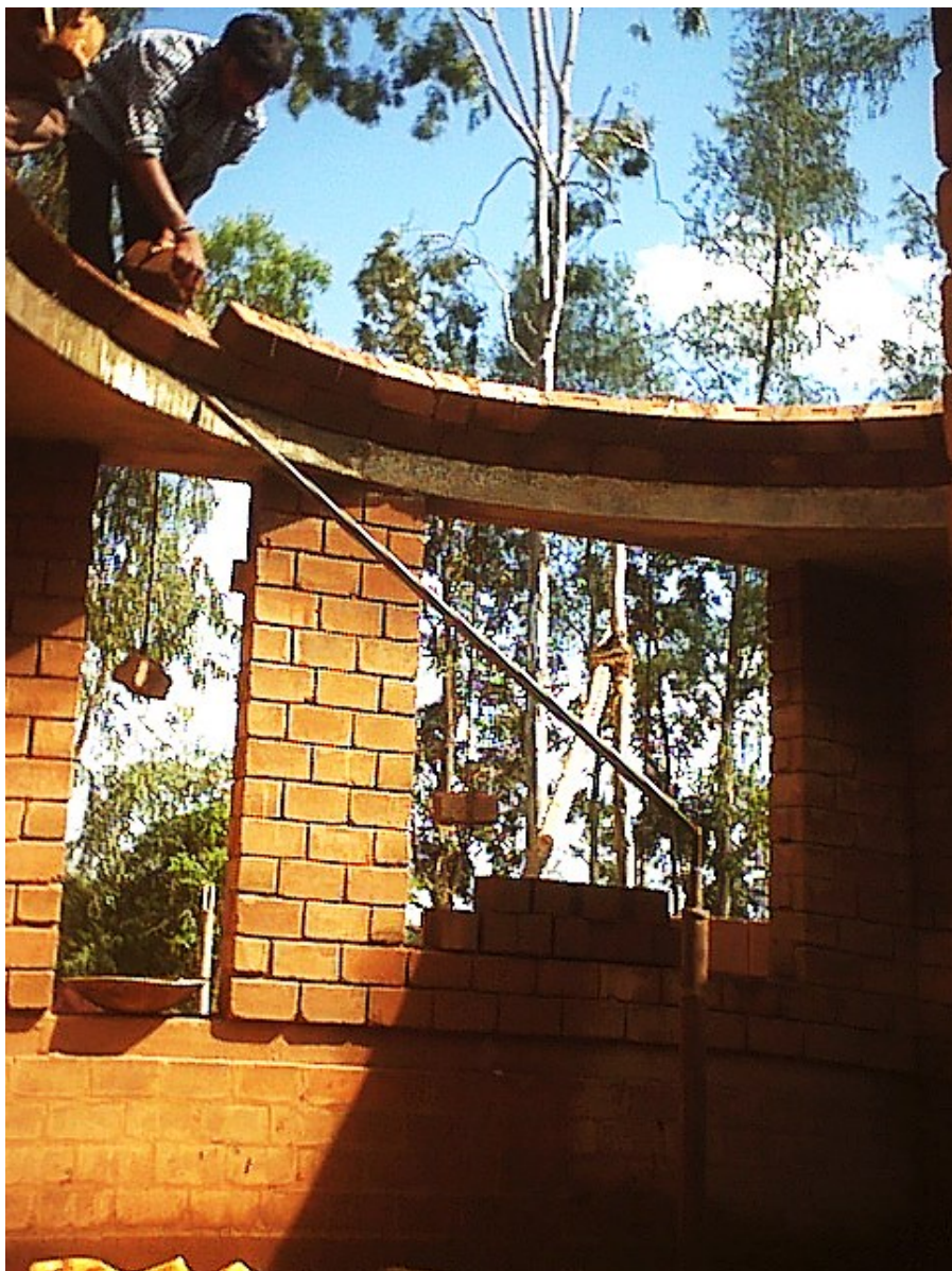
Фигура 240 Строителство на купол от пресовани земни блокове. На преден план се вижда металният водач. На заден план през отворите се виждат висящите тежести, които временно прикрепват тухлите от всеки следващ ред с метални куки. Бангалор, Индия. Арх. Читра Вишванат
