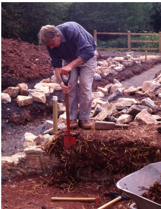
фигура 122 Оформяне на стената с права лопата на следващия ден.
