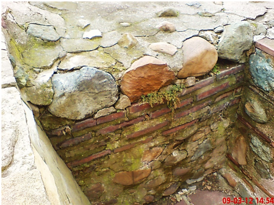
фигура 38 Зидария от речни камъни с цепени лица и тухлени изравнителни пояси, 5 век от н.е., София, ротонда "Св. Георги"
