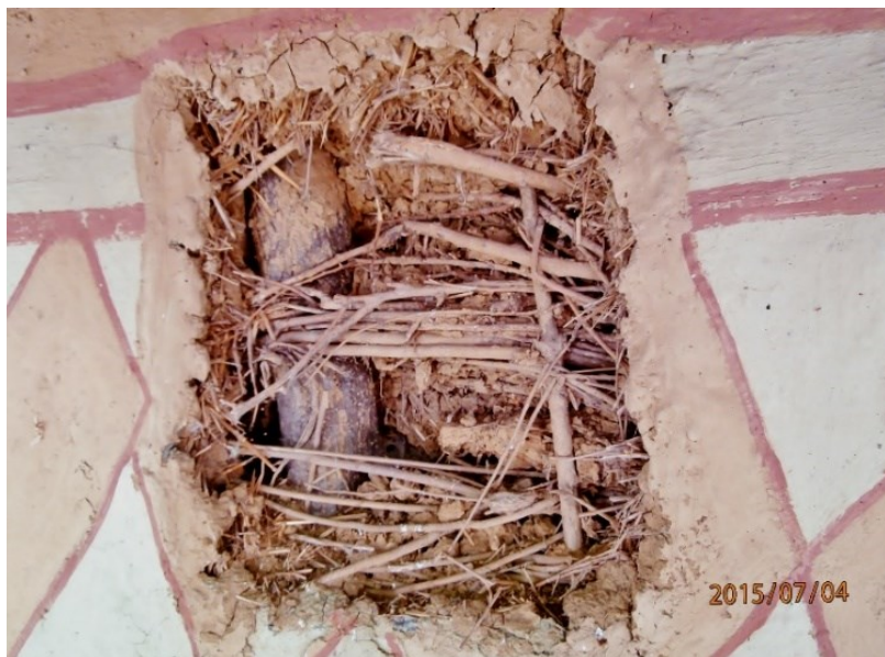
Фигура 2: Възстановка на колово-плетена, обмазана с глина конструкция. Част от стена на къща в неолитно музейно селище в Археологичен парк в Драганеци Олт, Румъния.
