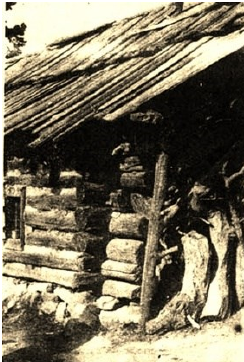
Фигура 53 Конструкция на дървена къща от цели борови греди, село Бабяк, Разложко (по Г. Данчов) [12]
