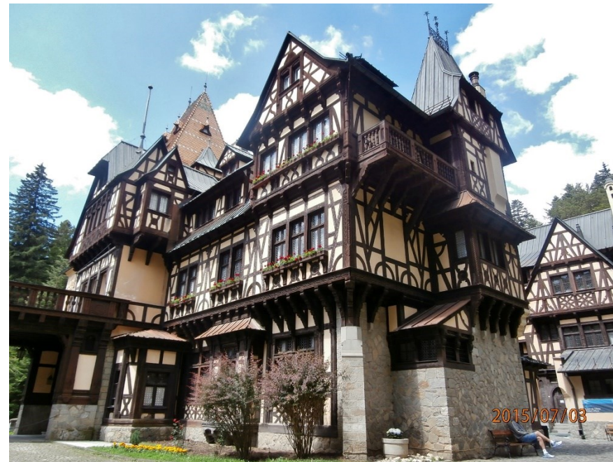
Фигура 85 Конструкция с изявен на фасадата дървен скелет. Дворец Пелишор, Синая, Румъния.
