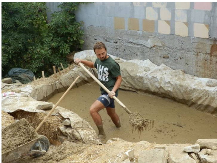
Фигура 36 Забъркване в корито, приготвено от платнище и бали слама.
