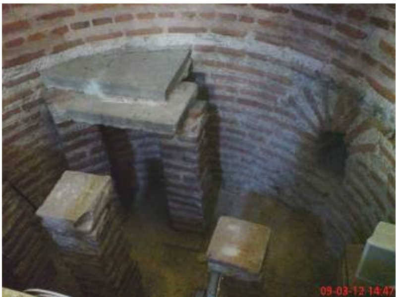
Фигура 318 Експонация на хипокауст от колонен тип, ротонда “Св. Георги”, София.
