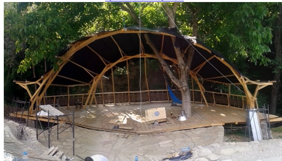
Фигура 263 Реципрочна конструкция на голяма сцена Trasfiguration 2015 с. Долен. Арх. Николай Маринов.
