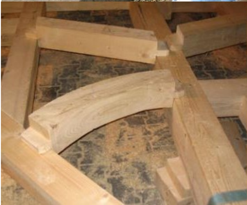
Фигура 86 Сглобки на паянтова конструкция.
