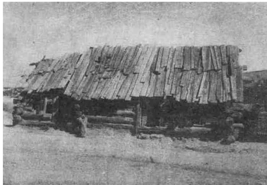
Фигура 187 Село Нова махала (сега Медени поляни), Велинградско. Къща с блоков градеж и дъсчен покрив, строена преди 1913 г. [8]
