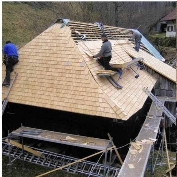
фигура 198 Направа на покрив с шиндли, Австрия.
