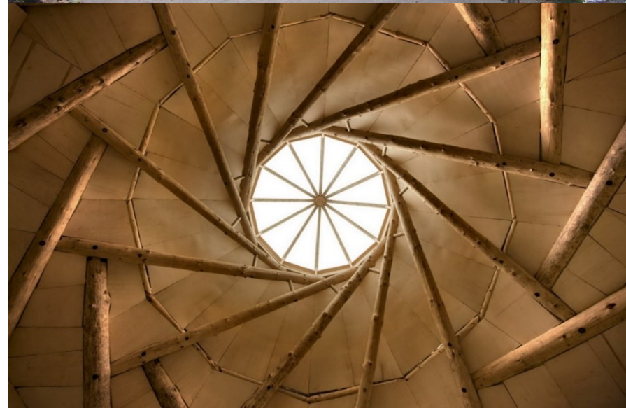
Фигура 259 Двоен реципрочен купол с диаметър 8 м в лекционна зала, Hill Holt Wood
