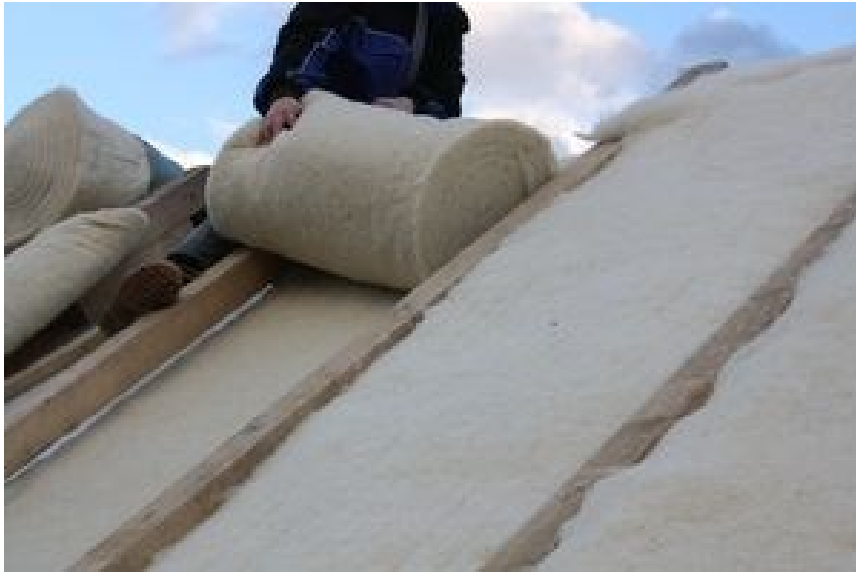
Фигура 175 Покривна теплоизолация от овча вълна. homenest
