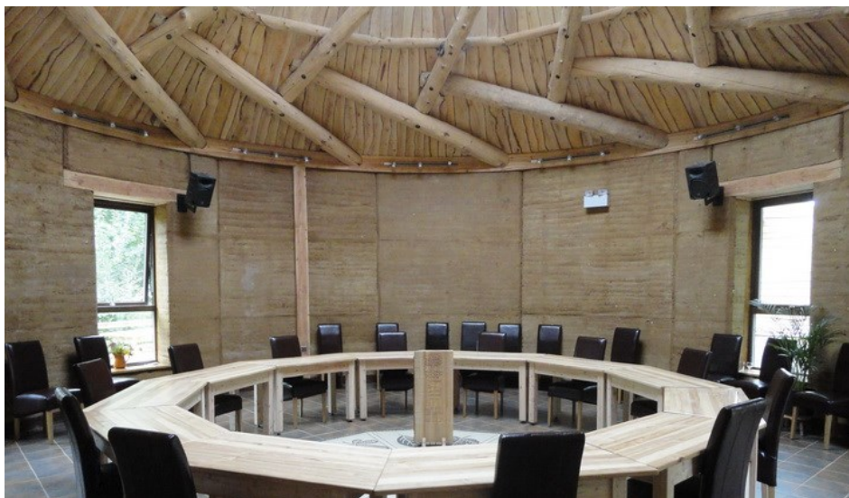
Фигура 152 Стени от трамбована земя на лекционна зала, Англия. rammedearthconsulting
