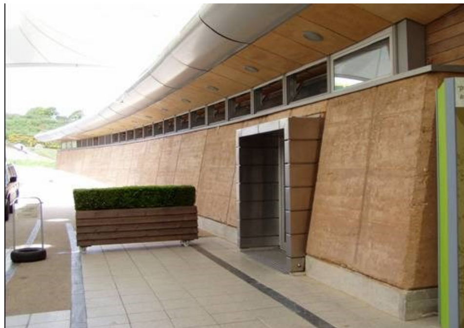
фигура 150 Стена от трамбована земя, посетителски център Eden Project, Корнуел, Англия. Jolyon BrewisArchitect, (Grimshaw Architects)
