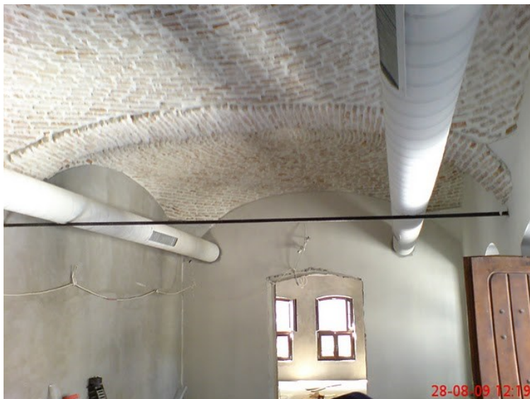
Фигура 229 За подовата конструкция на хана Хаджи Николи във В. Търново Майстор Колю Фичето използва куполи, стъпили върху арки с метални обтегачи.
