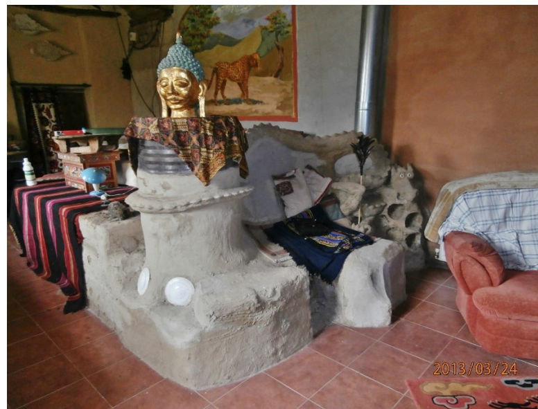
Фигура 338 Ракетна печка с топлообменник във формата на пейка и легло. Къща на Съюзън Хейгън в с. Хотница. В.Търново. 2013/03/24
