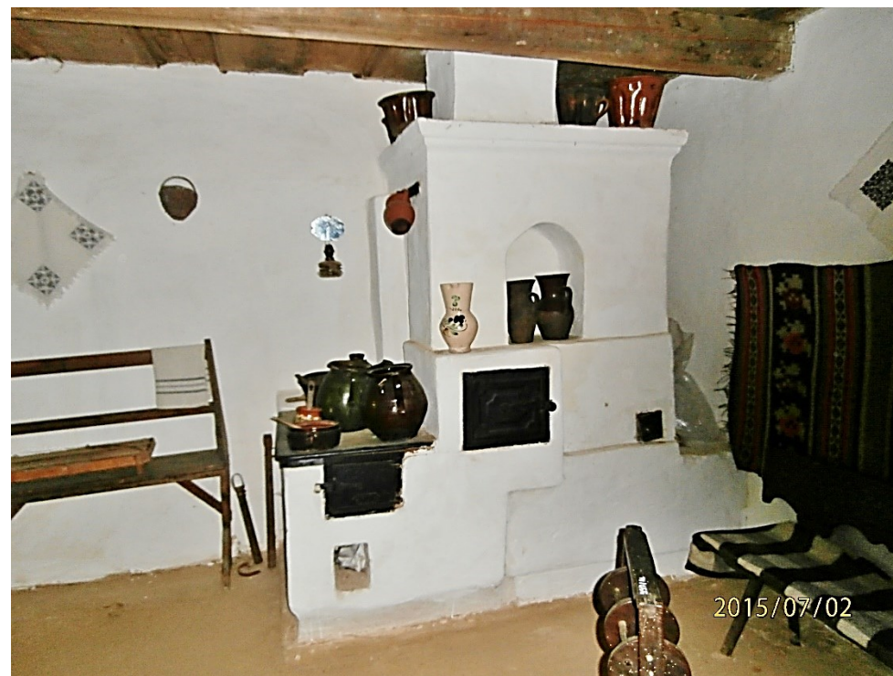
Фигура 333 Зидана печка с плота, фурна и теплообменник с канали, Музей Астра в Сибиу, Румъния.
