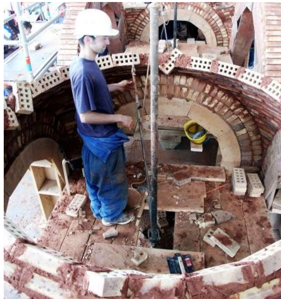
Фигура 239 Изграждане на сферичен купол. Снимка CRATERRE.
