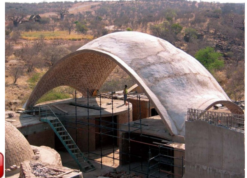
Фигура 250 Куполите са от два слоя тухли, покрити със замазка. Подпорното разстояние достига 18 м. Посетителски център в Национален парк Мапунгубв, Южна Африка.
