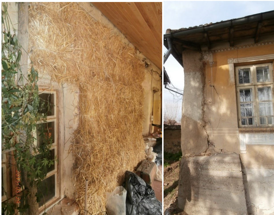
Фигура 182 Стенни топлоизолации със слама. Снопчета от слама, привързани към стената преди тяхното измазване (ляво) и сламени бали с мазилка върху рабицова мрежа (дясно).
