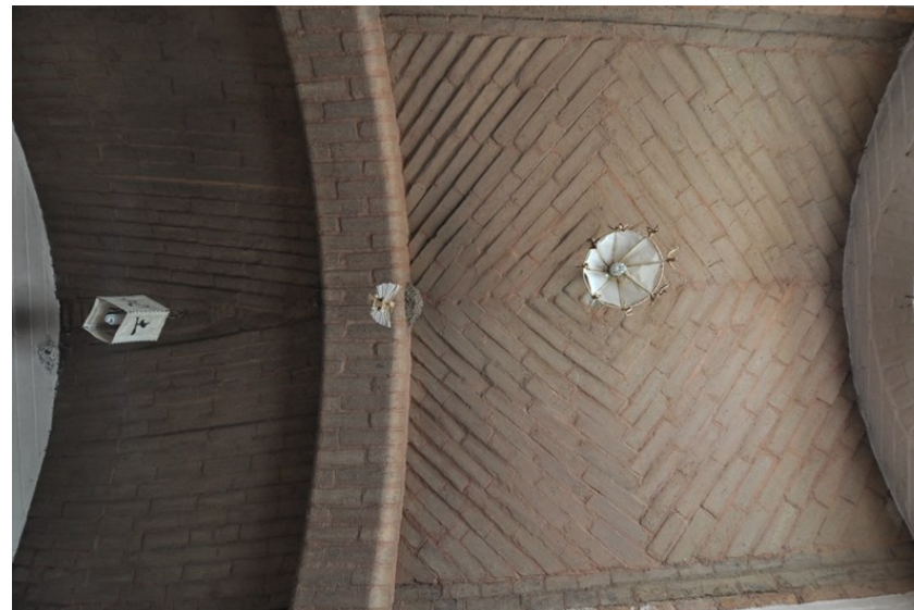
Фигура 275 Два различни мотива при свод от земни блокове. Посоката на отделните редове следва технологичната логика на изграждането.
