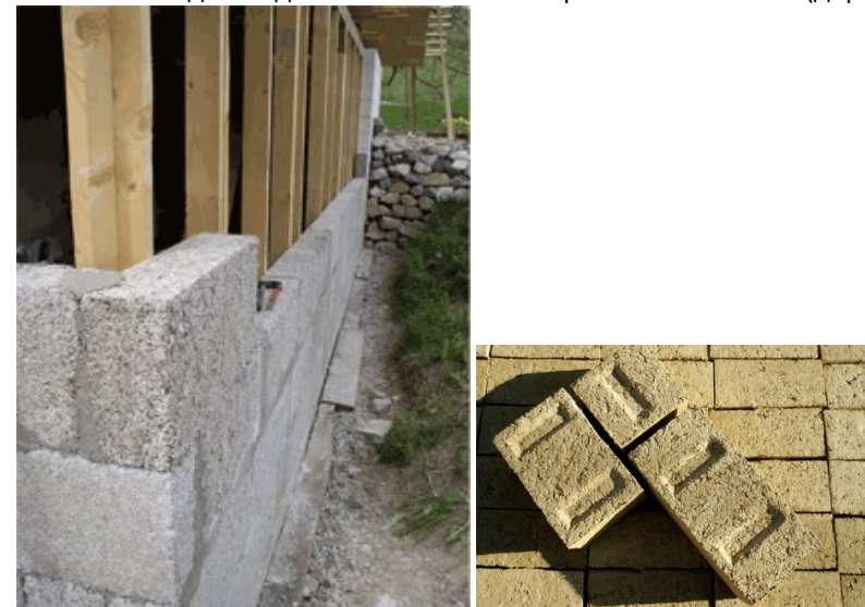
Фигура 174 Блокчета от конопен бетон HEMPCRETE
