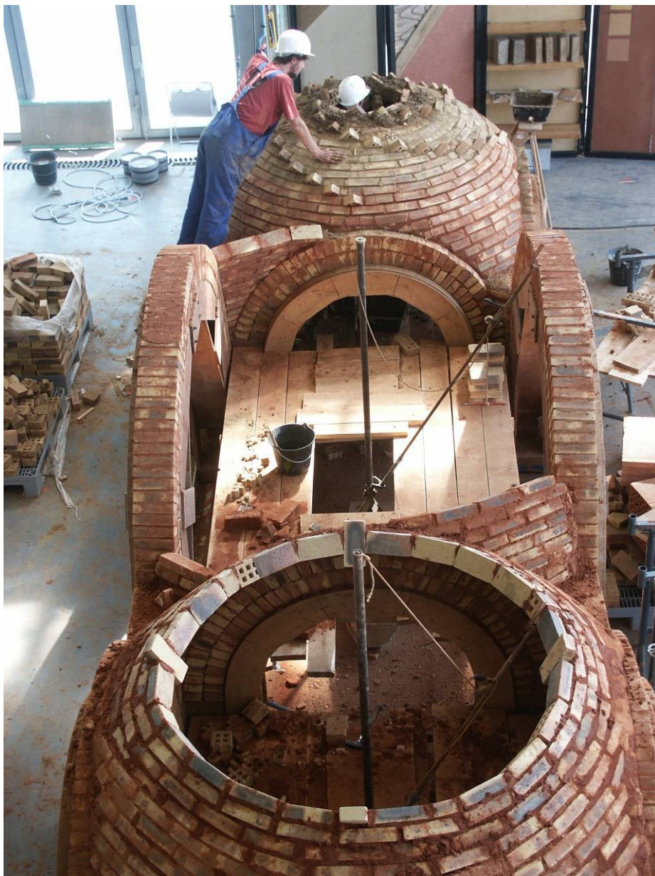
Фигура 226 Демонстрация на строителство на куполи. Grains d'Isere 2003 Craterre
