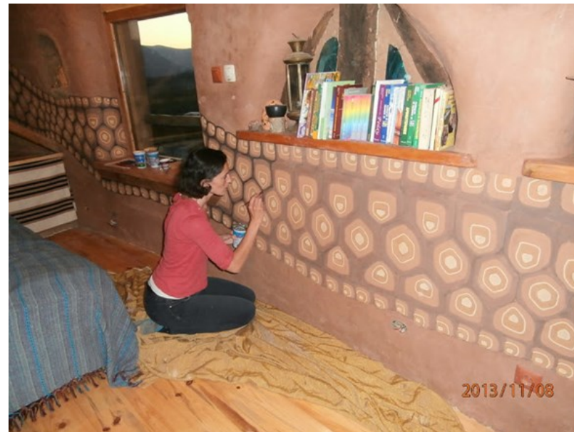
Фигура 171 Рисуване с глинени бои върху глинена мазилка.
