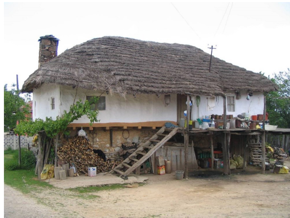
Фигура 207 Къща със покрив от дълга немачкана слама, Странджа, Турция. Снимка Елка Минчева.
